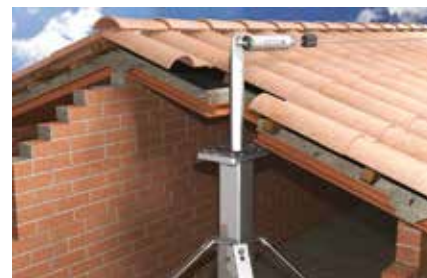
Dettaglio: fissaggio palo di estremità
