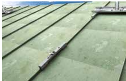
Messa in sicurezza copertura lamiera aggraffata
