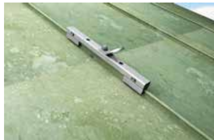
Dettaglio: punto di ancoraggio PSS A
