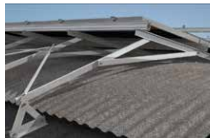
Dettaglio: vista posteriore struttura
