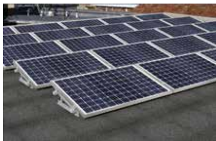
Tetto piano senza muro perimetrale
