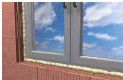
Giunti di connessione di serramenti
