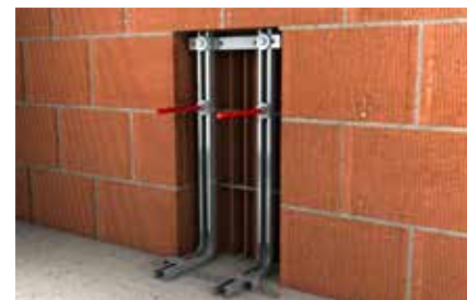
Dettaglio: installazione sistema L Plus
